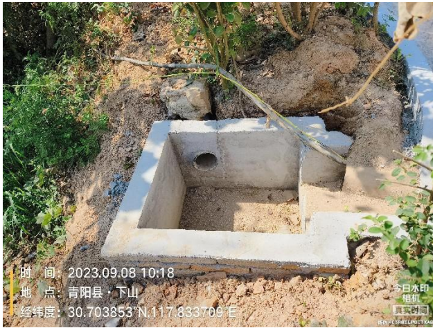
厂区门口路面处雨水排水沟
