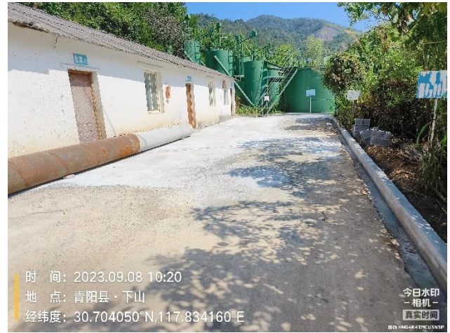
厂区门口路面处雨水排水沟
